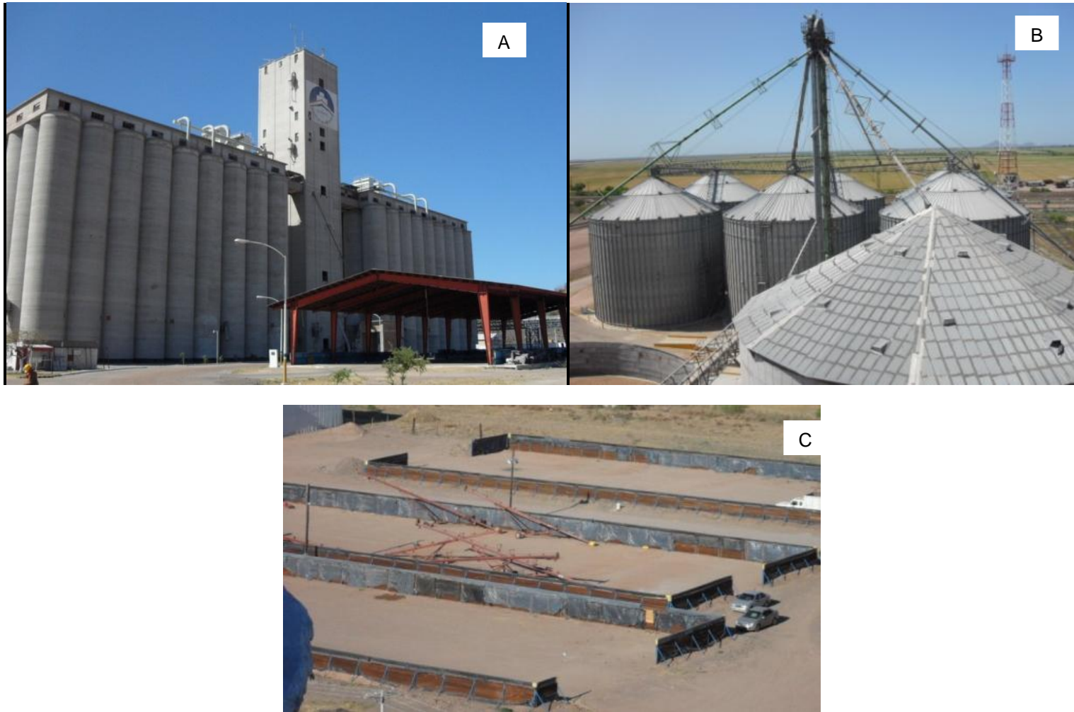
Figura 2. Almacenes de trigo en el Estado de Sonora; A) Silos de Concreto, B) Silos de Acero, C) Patios de almacenamiento al aire libre.
