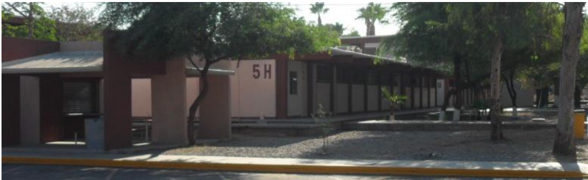
Edificio 5H – Nutrición, Bioquímica y Entomología del Departamento de Investigación y Posgrado en Alimentos de la Universidad de Sonora
