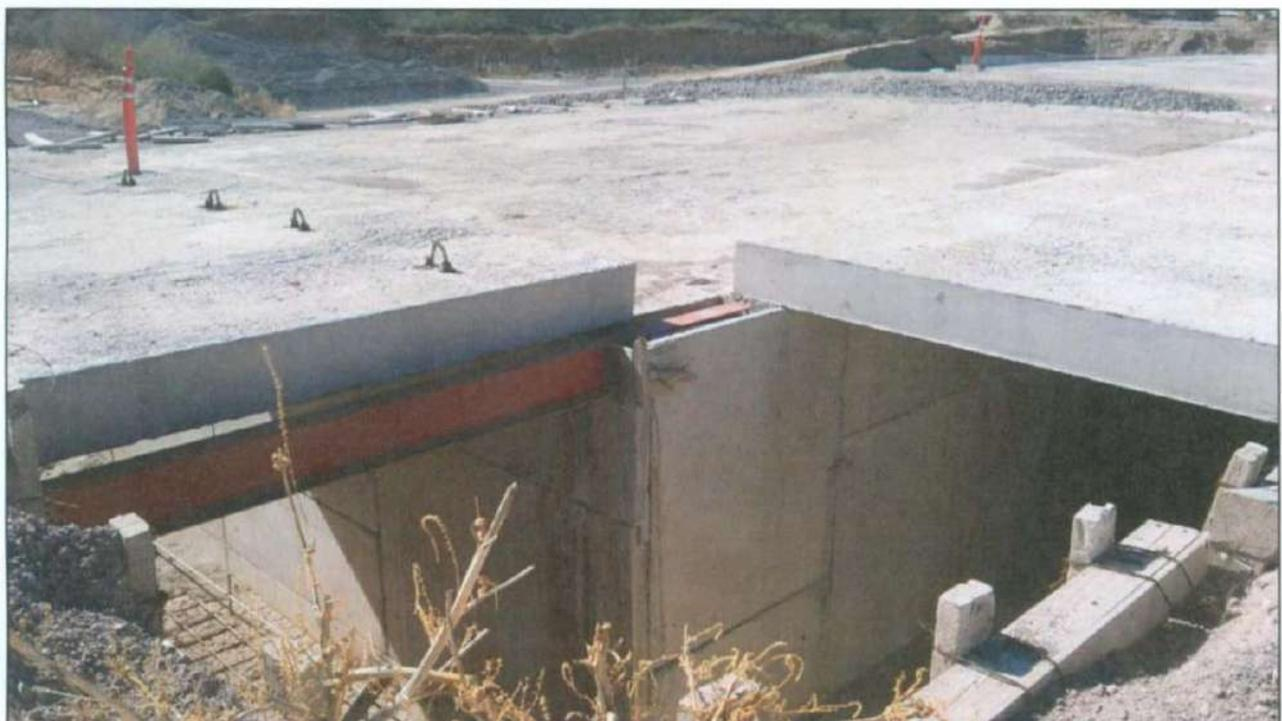
Galerías de inspección en el Dique de CCR en presa Pilares.
