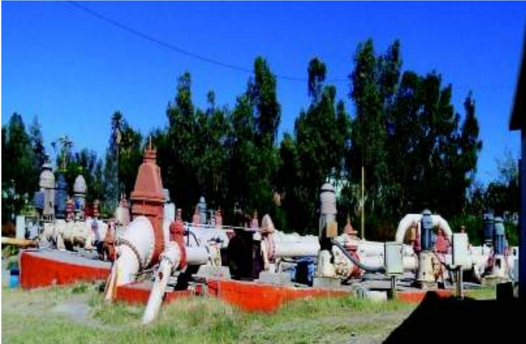
Figura 19. Tuberías en mal estado, oxidadas y sin códigos de color e identificación.
