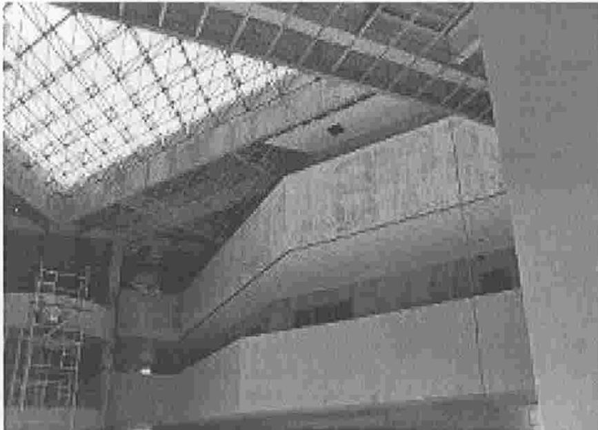
Fig. 2.12. Estructura triodética a base de perfiles laminados en frío.
