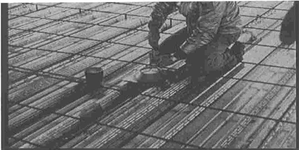
Fig. 2.15. Deck utilizado como plataforma para colar piso.
