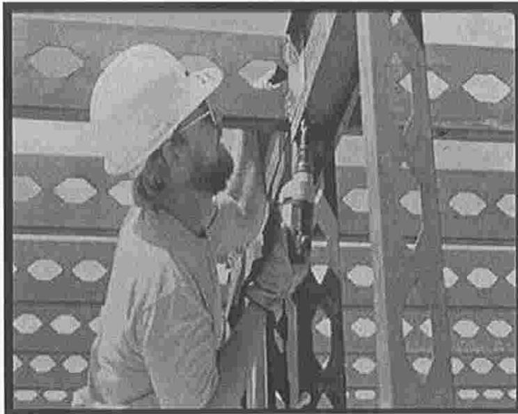
Fig. 2.10. Instalación de perfiles con agujeros.
