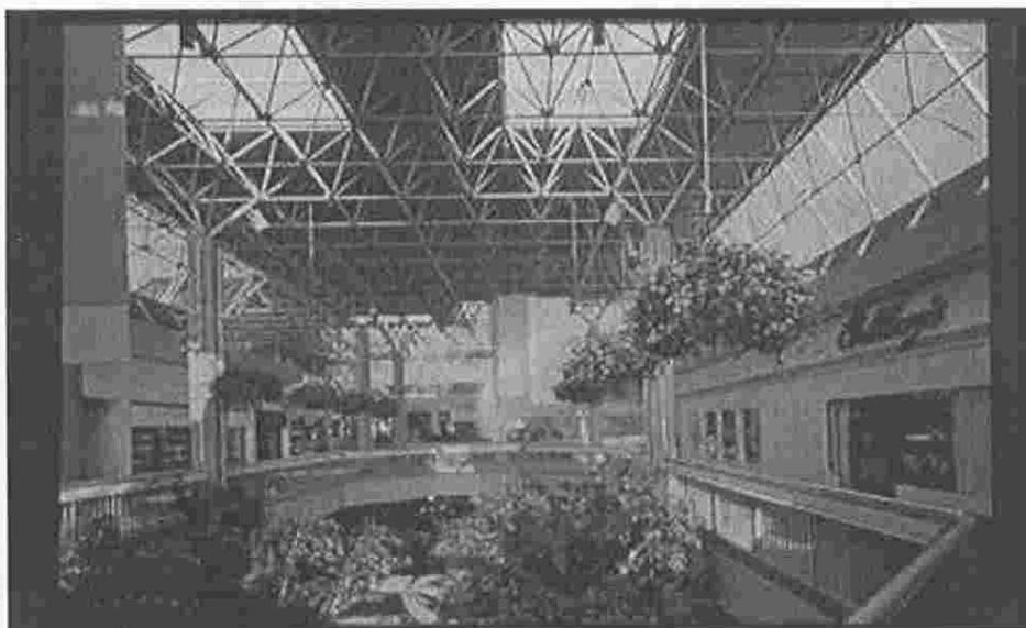
Fig. 2.1. Centro comercial construido a base de combinación de perfiles laminados en frío y laminados en caliente.
