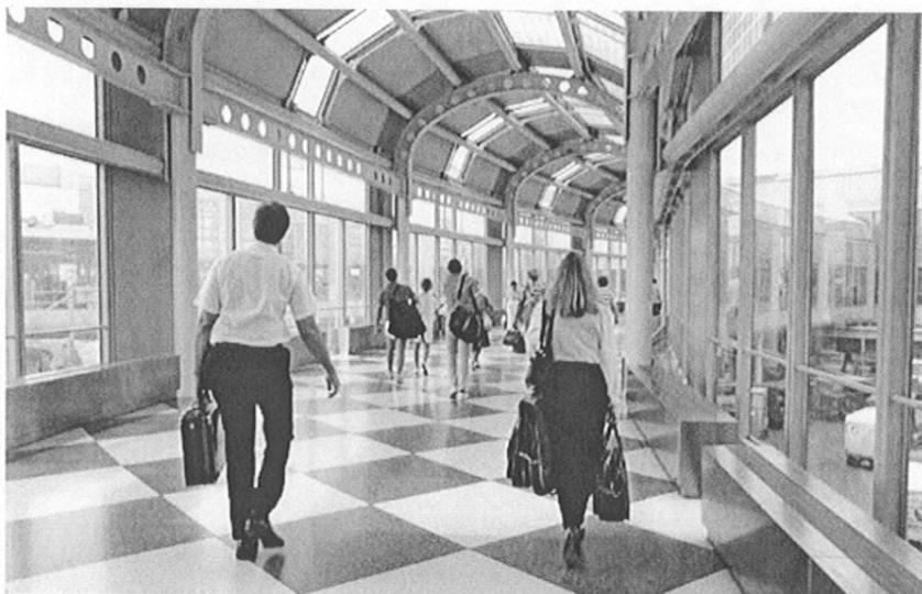
Fig.2.6 Perfiles agujerados con fines arquitectónicos en estructura principal de la cubierta.
