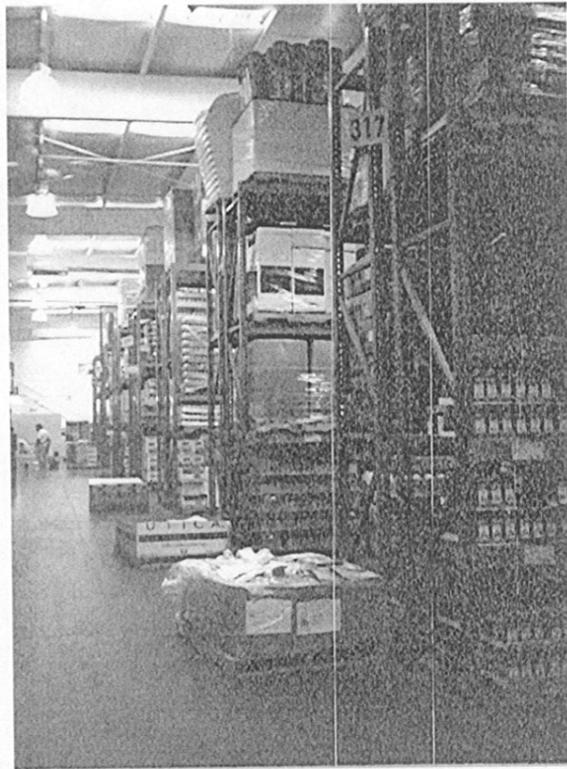
Fig.2.7 Estantería comercial o racks formados con perfiles laminados en frío.
