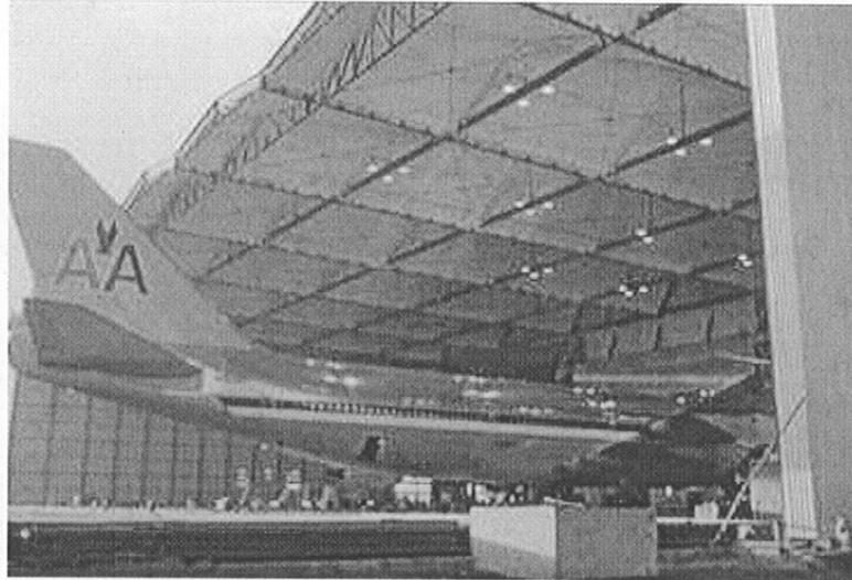
Fig. 2.9 Estructura para cubierta a base de perfiles laminados en frío.
