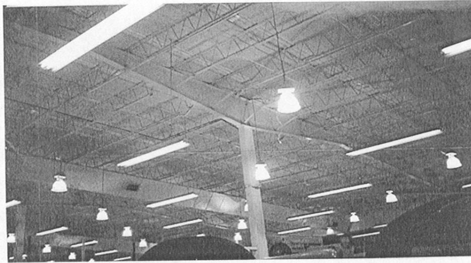
Fig.2.4 Centro comercial a base de marcos rígidos en la estructura primaria y joist a base de elementos laminados en frío y lámina corrugada en la estructura secundaria.
