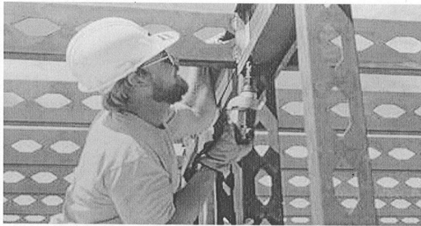
Fig. 2.5 Perfiles Agujerados con fines estructurales.
