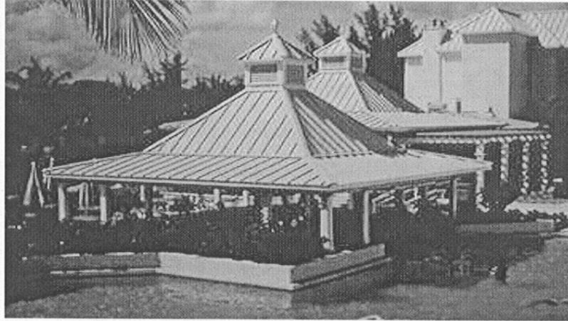
Fig. 2.12 Sistema de cubierta a base de lámina engargolada con costuras sobresalientes.
