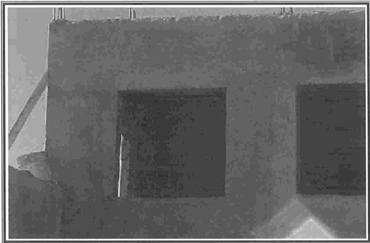
Este es un tipo de aplanado que se aplica una vez terminado un muro ya sea de block o ladrillo, este consiste en elaborar una pasta a base de cemento-arena, cal-arena o cemento-cal-arena, la mas común es la segunda en una proporción 1:5, la cual sirve para cubrir las imperfecciones del mismo y también de base para aplicar el aplanado fino, o
