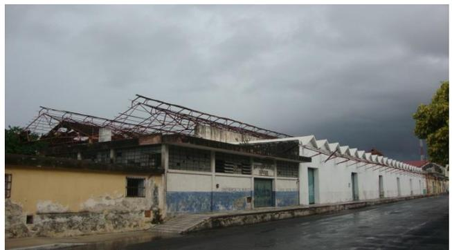
**Imagen 21.** Calle 48, mostrando el deterioro de la cubierta central, por las inclemencias del tiempo.
