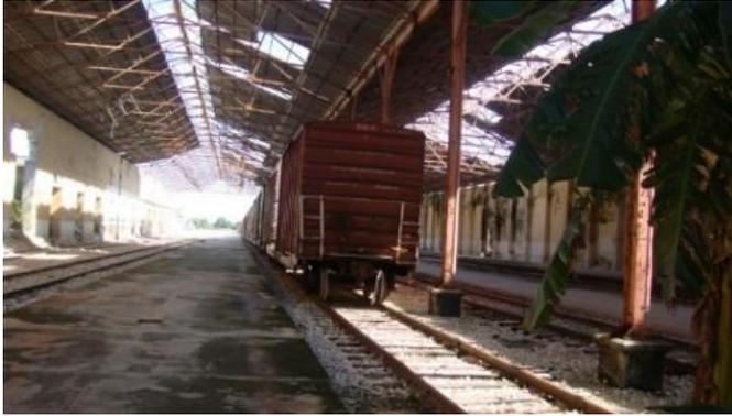
Imagen 14. Área de los andenes abandonada actualmente, donde se percibe el deterioro de la cubierta, pisos, muros y columnas.
