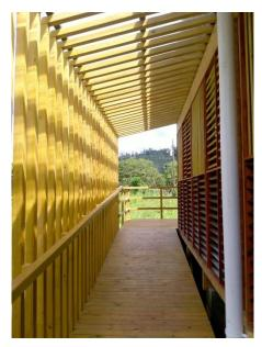
Imagen 17: Pasillo con ventilación del Centro de Capacitación.
