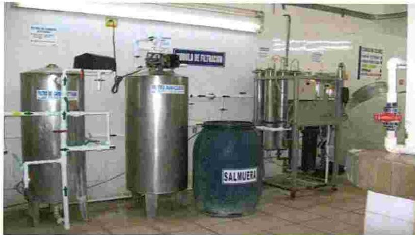
**Fig. 6:** Área de filtros para la purificación del agua.
