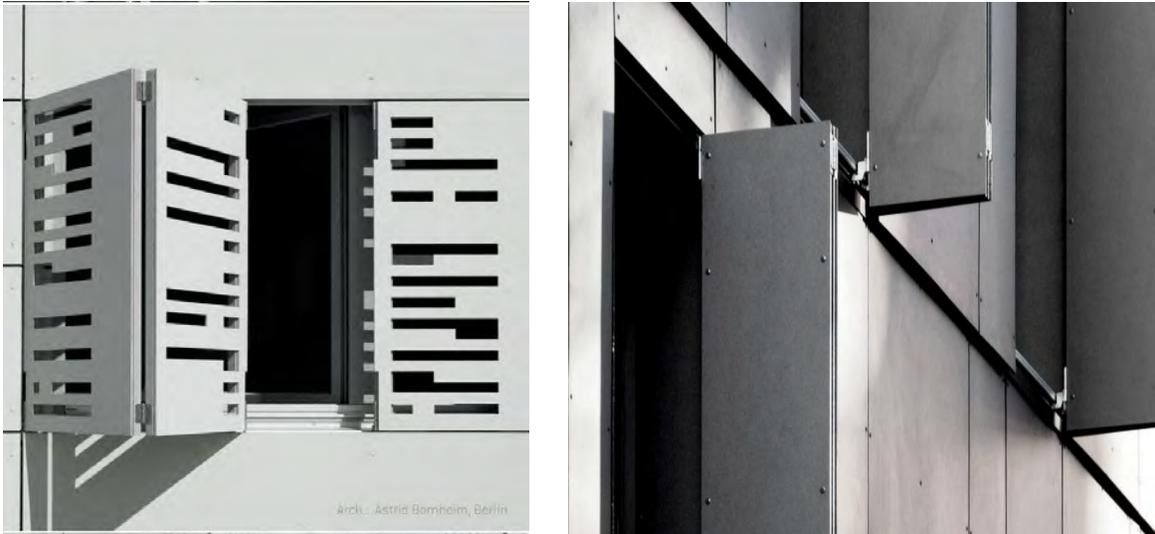
Ilustración 48- Protecciones solares y envolventes de placas de fibrocemento Equitone
