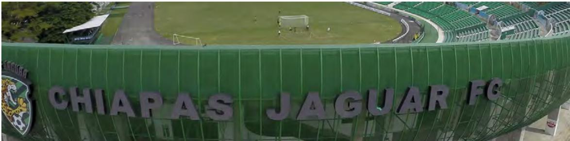
Ilustración 49- Envolverte de acero micro perforado
