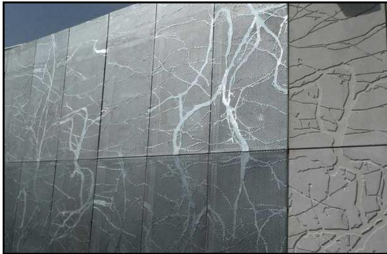
*Fotografía 2.7.- Muro construido por paneles de hormigón monolítico*
