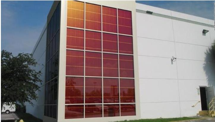
Imagen 47.- Paneles solares adaptados a fachada de oficinas. Imagen de <http://mexico.cnn.com/media/2011/01/25/paneles-solares-plastico-gal02.jpg>
