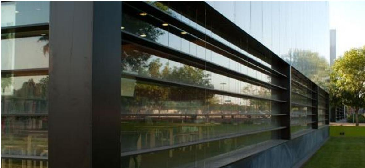
Imagen 35.- Detalle de columnas tipo C y tipo I con cancelería metálica y cristales. Fotografía de Michael Small
