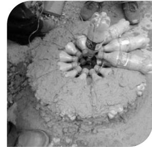
Estos elementos pueden remplazarse por columnas de concreto o madera. Pero por fines de reducción de costo se mantendrán a base de botellas rellenas. Las tapas deben formar un anillo simétrico en el centro, que se va amarrando a medida que se va colocando las botellas. La columna servirá de refuerzo para sostener la cubierta solicitada.
