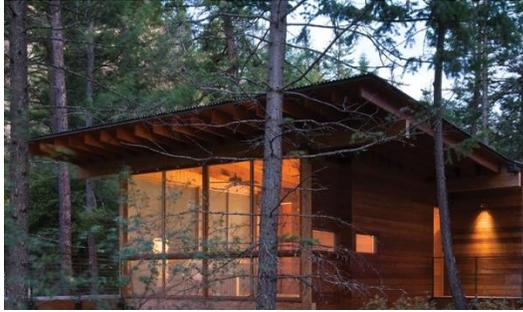
**Losa/cubierta:** serán cubiertas inclinadas para un mejor mantenimiento, debido a las hojas que caen de los árboles. Las losas serán a base de madera y lámina. (Ver imagen 3.6)
