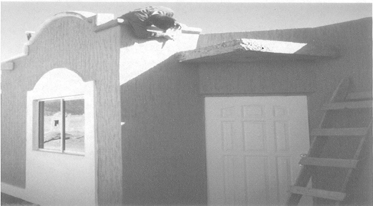
Fotografía. V.3.4.5.-(1) se aprecia la actividad del pintado de muros exteriores, el cual será el acabado final de la vivienda.
