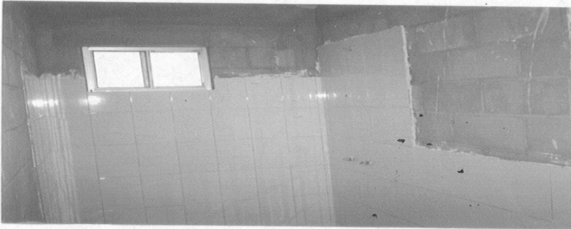
Fotografía.- V.3.4..6. (1).- Nos muestra la colocación del azulejo en muros del área de la regadera del baño de 20x25cm. y el piso es antiderrapante de 20x20cm.
