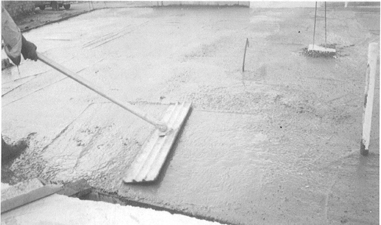
Fotografía: V.3.1.5.(3).- Procedimiento del colado de la losa de azotea, tiene 5cm de espesor, se observa la salida de la ventila del drenaje, esta losa tendrá un acabado semipulido.
