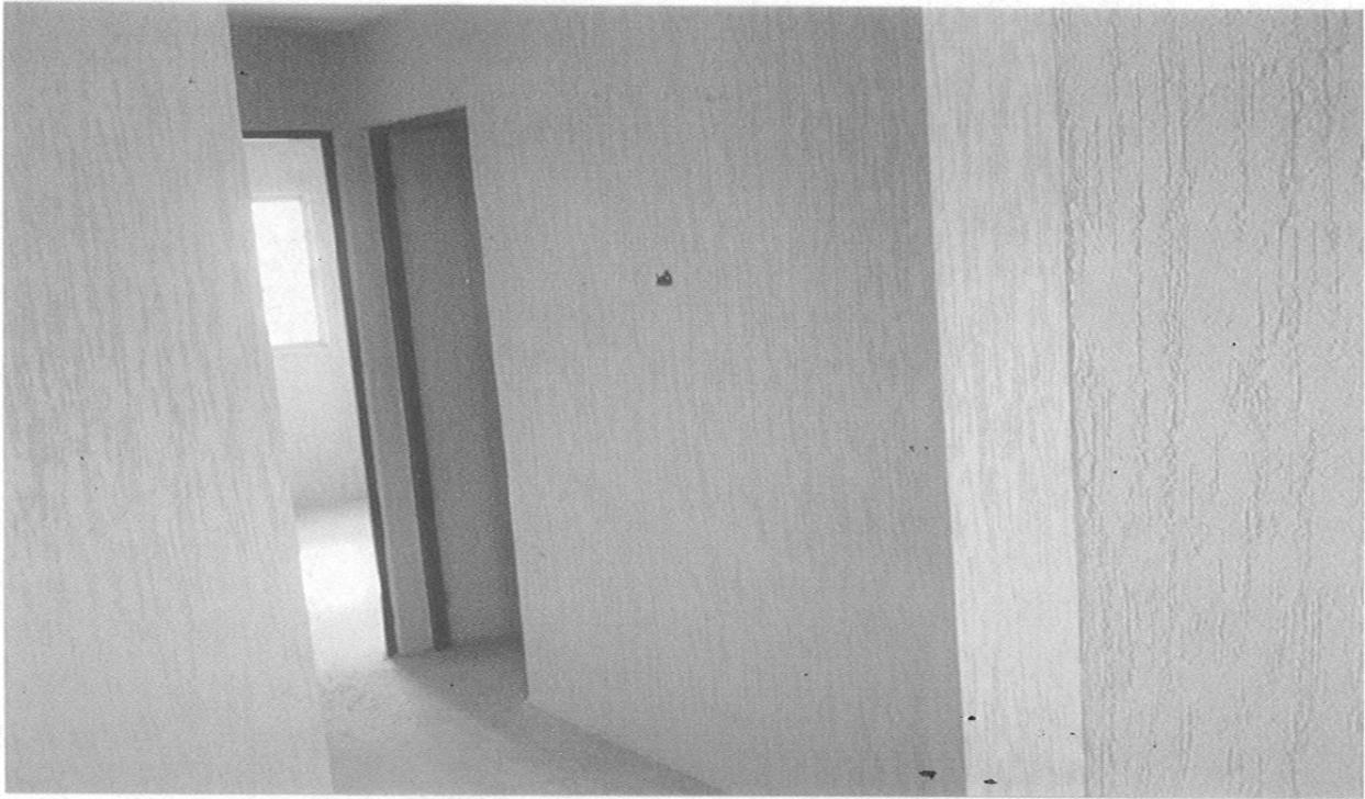
Fotografía.- V.5.4.(2) .- se aprecia el tipo de acabado que püdieran tener los muros interiores, este acabado es textura rayado horizontal.
