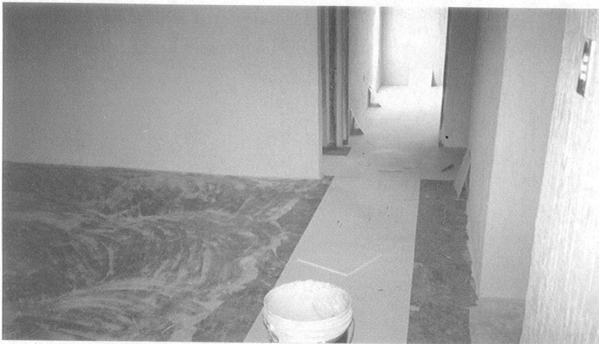
Fotografía.-V.3.4.6.(2) .- Se aprecia la colocación de la loseta vinílica, como el acabado y pintado de muros.
