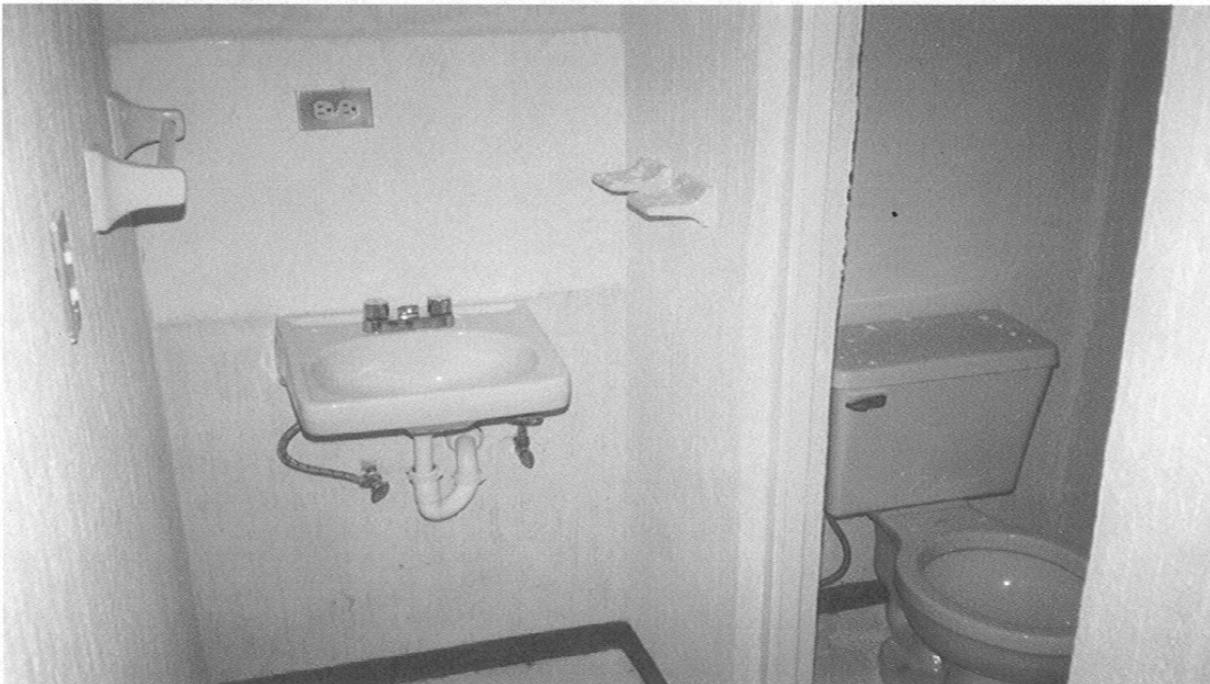
Fotografía.-V.3.4.7.(1) .- Se observa la colocación de los muebles sanitarios y los accesorios de porcelana.
