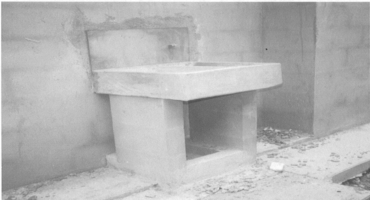
Fotografía.- V.3.3.(1).- En esta se observa la colocación de lavadero, el cual es empotrado sobre el muro de la vivienda y apoyado sobre pequeños muros, en ambos lados, este es uno de los trabajos de albañilería.
