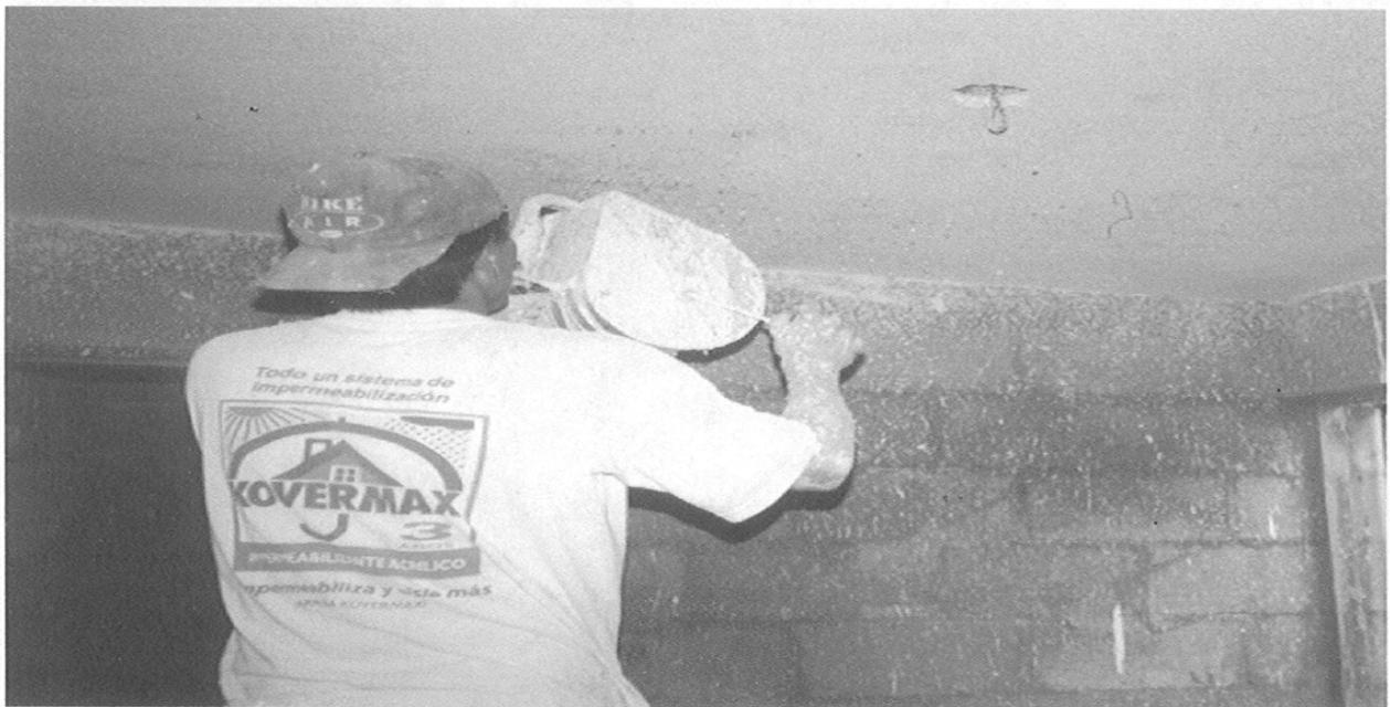
Fotografía.- V.3.4.3.(2).- Se observa el acabado final que tendrá la losa interior , la cual será a base de tirol (marmolina fina y cemento blanco).
