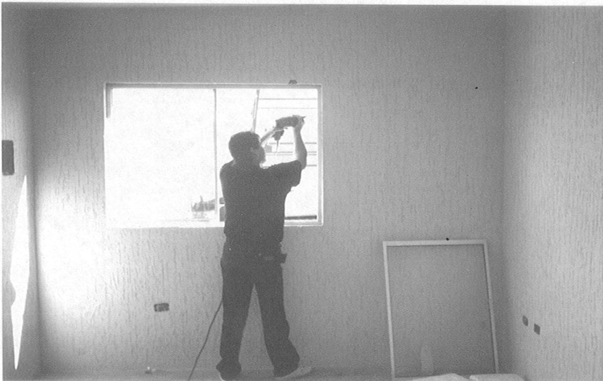
Fotografía.- V.3.4.9.- Colocación de ventanas, las cuales son empotradas sobre el muro, se utiliza aluminio claro de 2", vidrio de 3mm.
