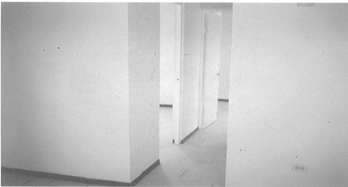
Fotografía.-V.3.4.6.(3).- Se aprecia el terminado de la colocación de la loseta vinílica y el zoclo, como el pintado de bastidores y muros. Los cuales presentan una calidad aceptable.
