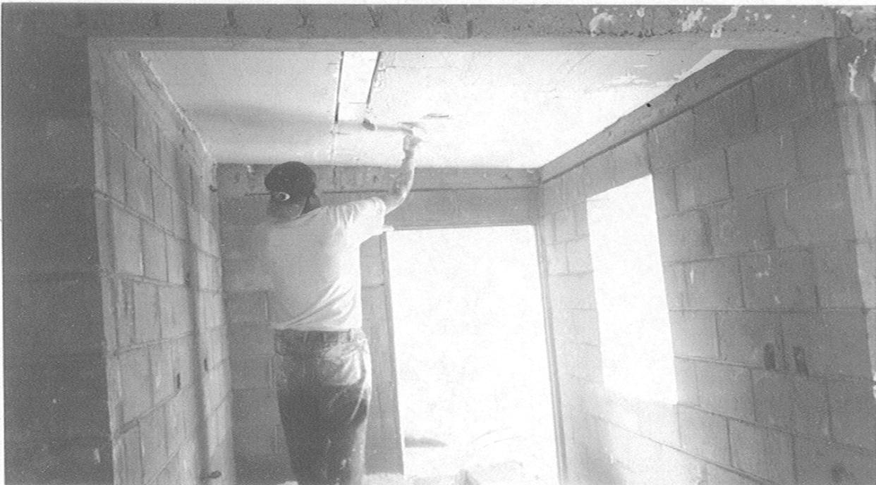
Fotografía.- V.3.4.3.(1)..- Nos muestra el acabado de yeso semipulido sobre toda el área de la losa interior de la vivienda, en área de la cocina es pulido.
