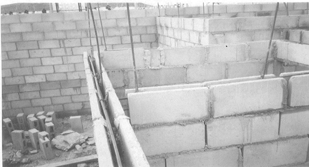
Fotografía .V.3.1.3.(1).- Nos muestra la colocación del acero en la onceava hilada, cual se coloca dentro del block dala, así mismo se procede a el colado de esta hilada.
