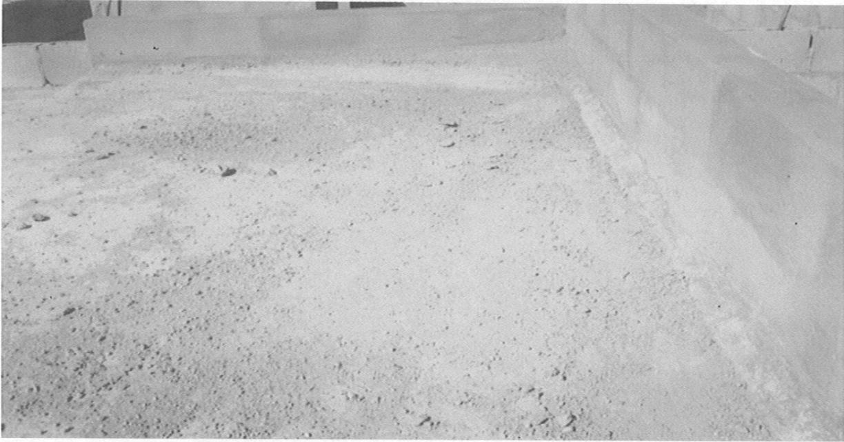
Fotografía.- V.3.4.2.(1) .- la cual muestra la construcción del chaffán y al fondo se muestra el diamante para darle salida al agua pluvial.
