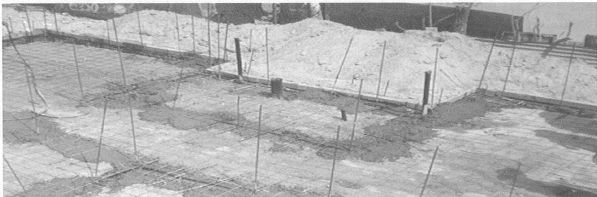
Fotografía.-V.3.2.5.(1).- Muestra una de las instalaciones que se realizan en la losa de cimentación, instalación sanitaria.
