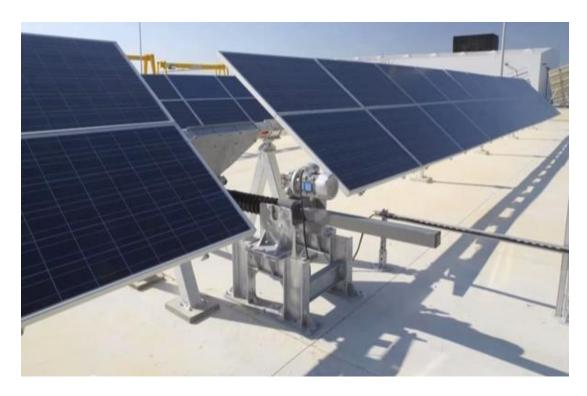
**Figura 2.7.** Modelo MS-1EH, el actuador lineal mueve varios arreglos de paneles dispuestos alrededor de un eje, situado de norte a sur (1 Axis Solar Tracker, 2012).
