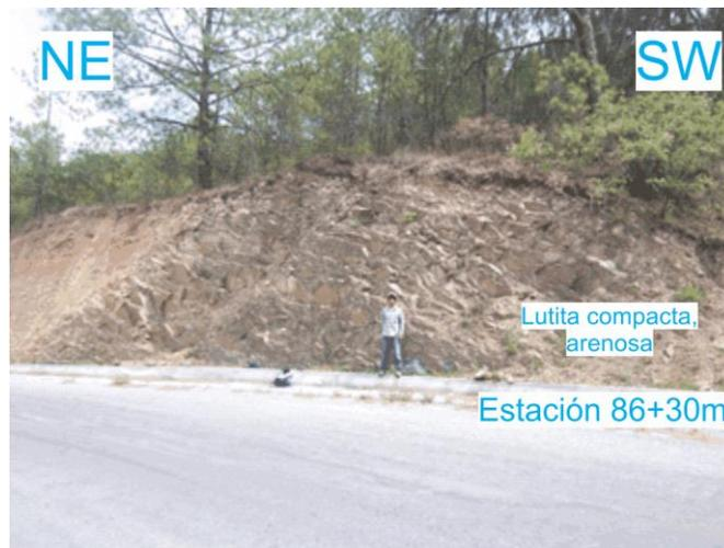
**Figura 66.** Fotografía de campo con orientación NE-SW, viendo al SE, mostrando el afloramiento expuesto en el intervalo de las estaciones 86 a 87. Se observa que el paquete de lutita compacta, arenosa se encuentra prácticamente a rumbo con la dirección de la carretera.
