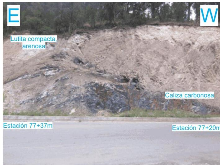
**Figura 54.** Fotografía de campo con orientación E-W, viendo al sur, mostrando el afloramiento expuesto en el intervalo de las estaciones 77, 78 y 79. El paquete que se observa al oeste es el de caliza carbonosa mientras que al este se muestra aflorando, en la parte superior, la lutita compacta, arenosa (**Figura 56**).
