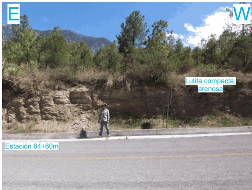
**Figura 41.** Fotografía de campo con orientación E-W, viendo al sur, mostrando el afloramiento expuesto en el intervalo de las estaciones 64 a 65. Se puede observar que el camino y el rumbo del paquete de lutita compacta, arenosa -es decir, la orientación de éstos dos elementos- mantienen ligeramente la misma dirección, el rumbo de los estratos es paralelo al camino (**Figura 42**).
