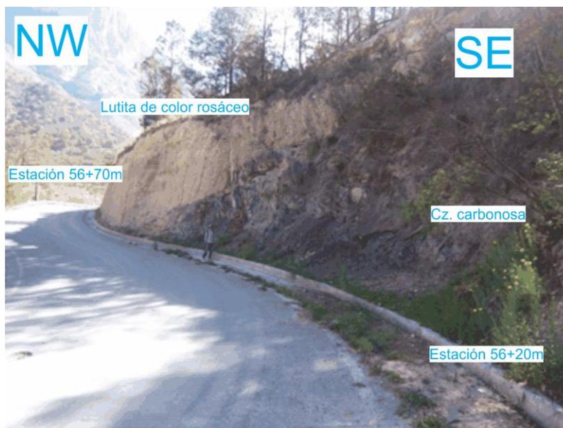
**Figura 29.** Fotografía de campo con orientación NW-SE, viendo al NE, mostrando el afloramiento expuesto en la estación 56+20 m. Se observa la caliza carbonosa en contacto discordante con la lutita de color rosáceo.
