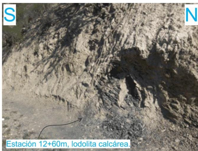
**Figura 8.** Fotografía de campo con orientación S-N, viendo al oeste, mostrando el afloramiento expuesto en el intervalo de las estaciones 11 a 12, se observa el carácter deleznable de las lodolitas.
