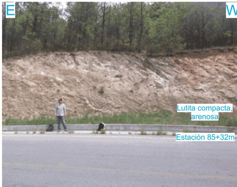
**Figura 64.** Fotografía de campo con orientación E-W, viendo al sur, mostrando el afloramiento expuesto en el intervalo de las estaciones 85 a 86. Se observa que el paquete de lutita compacta, arenosa se encuentra prácticamente a rumbo con la dirección de la carretera.
