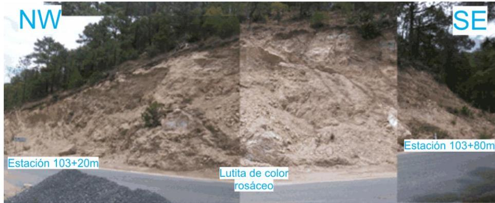
**Figura 82.** Fotografía de campo con orientación NW-SE, viendo al NE, mostrando el afloramiento expuesto en la estación 103+0 m. Se observa el color característico de la lutita de color rosáceo, la cual es altamente deleznable.
