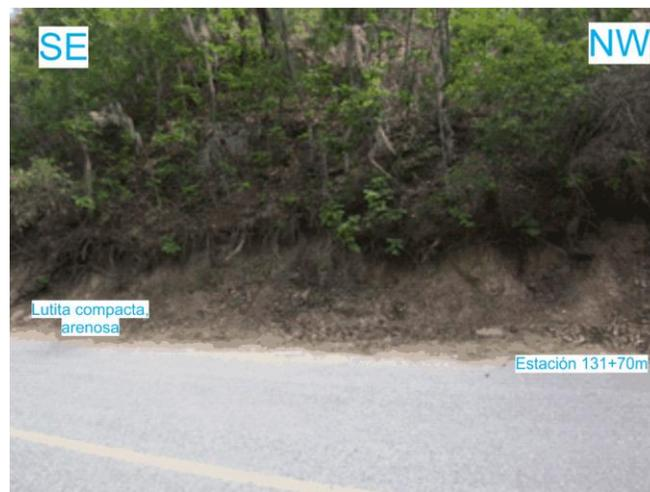
**Figura 109.** Fotografía de campo con orientación SE-NW, viendo al SW, mostrando el afloramiento expuesto en el intervalo de las estaciones 131 a 132. Se muestra el paquete de lutita compacta, arenosa de color pardo claro, el afloramiento está fuertemente alterado, no obstante, se pueden observar las características del mismo.
