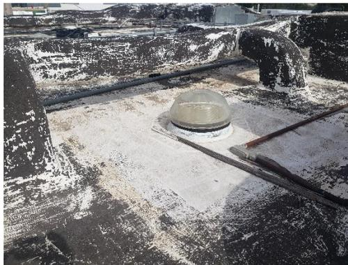
**Figura 16. Domo SOLATUBE en desuso instalados en el techo del edificio.**
