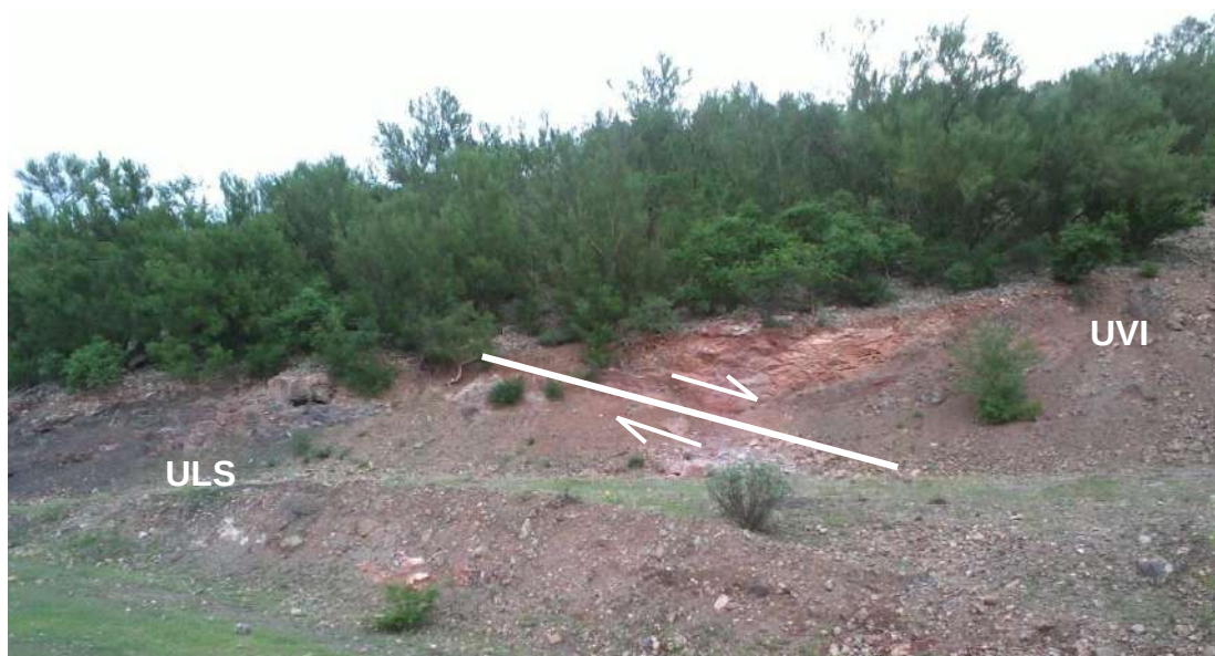
Figura III.14. Corte de La Verde. Contacto por falla normal entre Limolitas Síliceas (ULS) y Unidad Volcánica Inferior (UVI).
