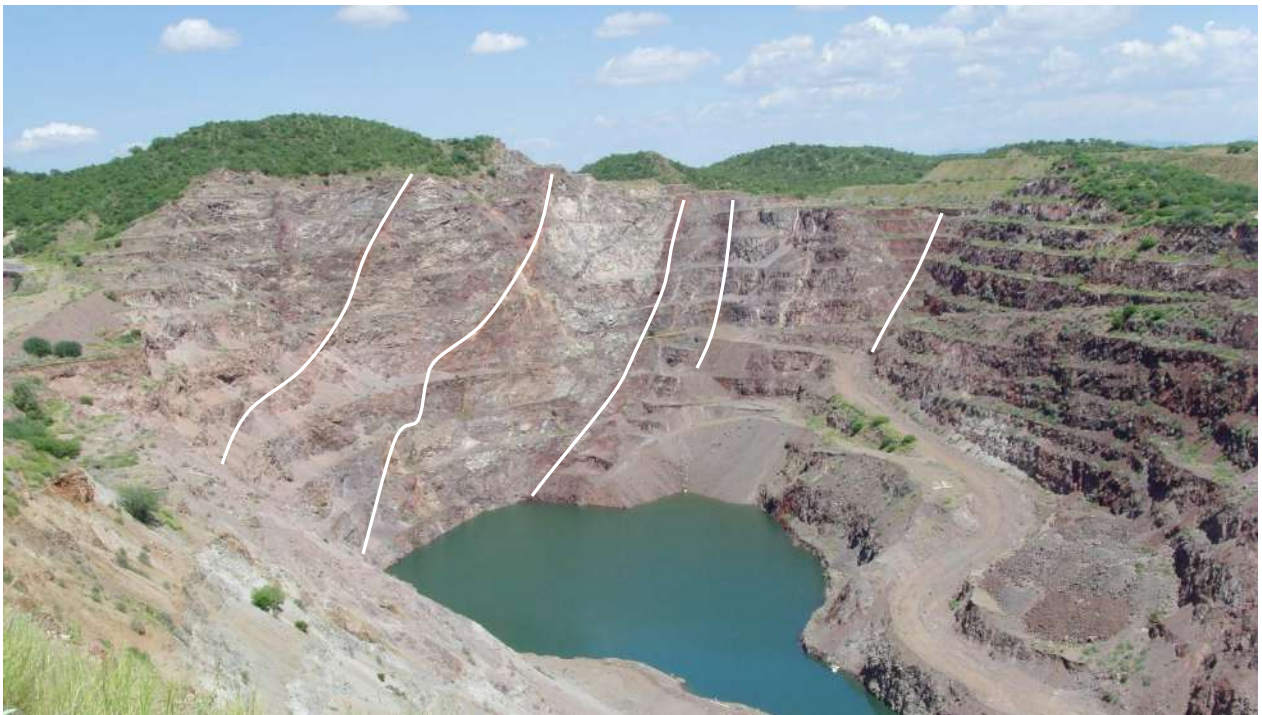
Figura III.11. Tajo El Crestón viendo hacia el ENE. Se remarcen las fallas principales que corresponden a fallas normales que buzan al NW
