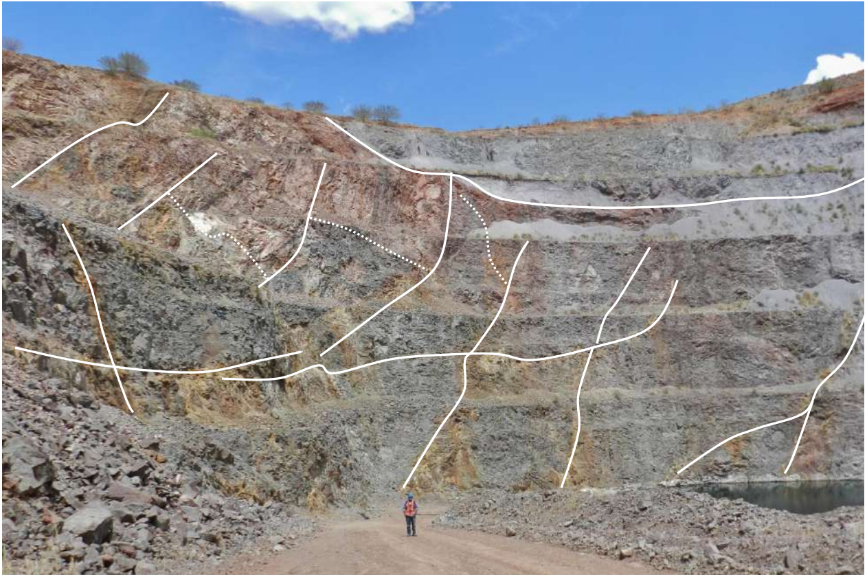
Figura III.4. Tajo Gran Central viendo al este. Intrusivo Diorítico (DT), Intrusivo Granítico Porfídico (IGP). Se resaltan las fallas principales (línea continua) y los contactos irregulares entre las dos unidades mencionadas (línea discontinua).
