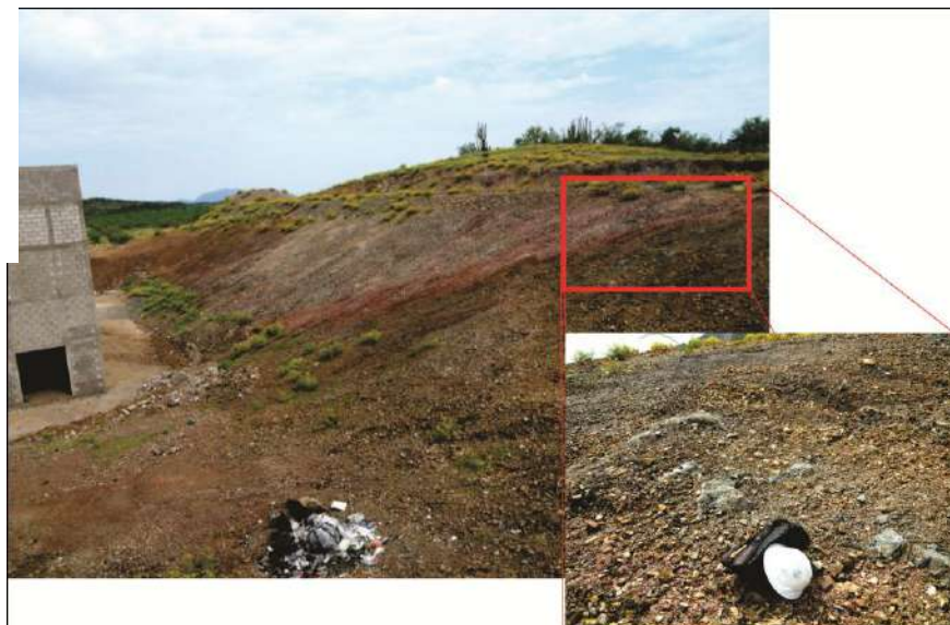
Figura II.16. Fotografía viendo al NW de un corte a espaldas del CUM de pueblo de La Colorada donde subaflora la unidad Volcánica Inferior.
